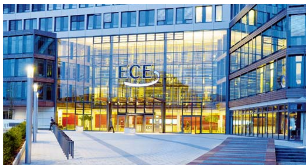
Die Unternehmenszentrale in Hamburg-Poppenbüttel: Hier arbeiten 1.100 ECE-Mitarbeiter. Das ist ein Drittel der gesamten Belegschaft
